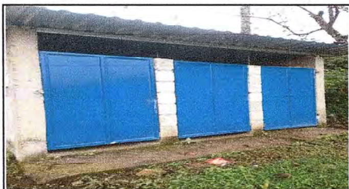
Foto 3: SUSTITUCION DE PUERTAS DE BAÑOS
