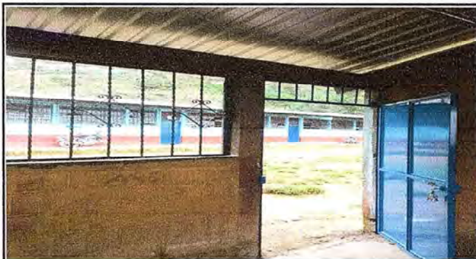
Foto 1: TERMINACION DE COLOCACION DE PUERTA DE COCINA
