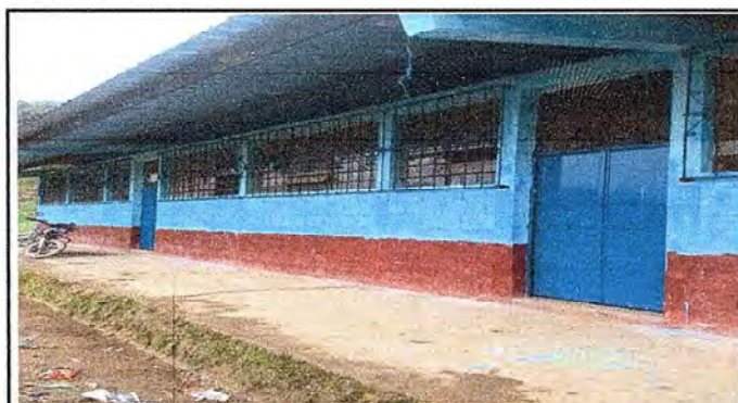
Foto 4: SUSTITUCION DE PUERTAS DEL ESTABLECIMIENTO Y BALCONES (20 BALCONES)
